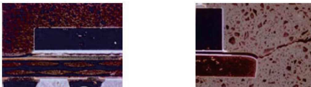
图 4-10 封装破裂照片
